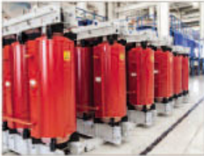
Kuru Tip Transformatörler
