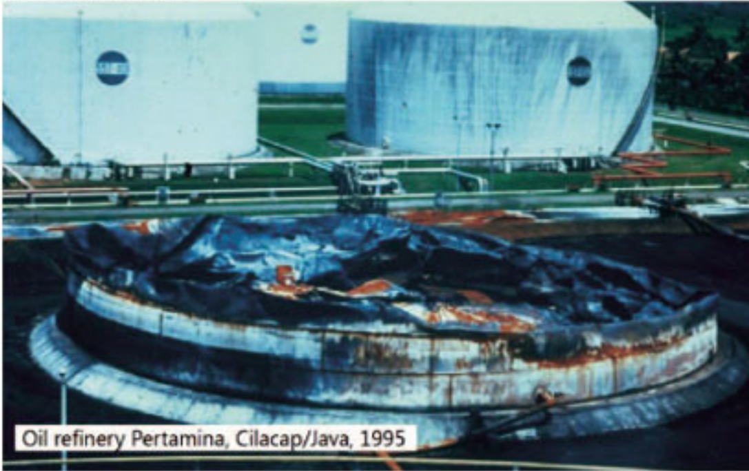
Resim2- Yıldırım sonrası 7 adet tankın hasar görmesi
