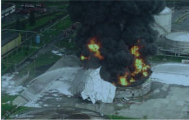
Resim1- İç Yüzer Tavanlı Tankta oluşan Yıldırım Kaynaklı Hasar- Polonya, Trzebinia Rafinerisi
