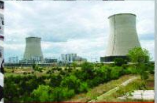
Hamitabat Termik Santrali Soğutma Kuleleri Çekmeceli Mcc Panelleri
