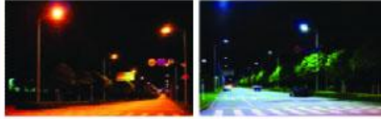
Şekil 1: Sodyum Buharlı Lamba ile LED'li Armatürlerin Renksel Geriverim Değerleri Arasındaki Fark [2]
