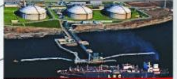
Botaş Lng Terminali Adp ve Mcc Panelleri Değişimi Projesi
